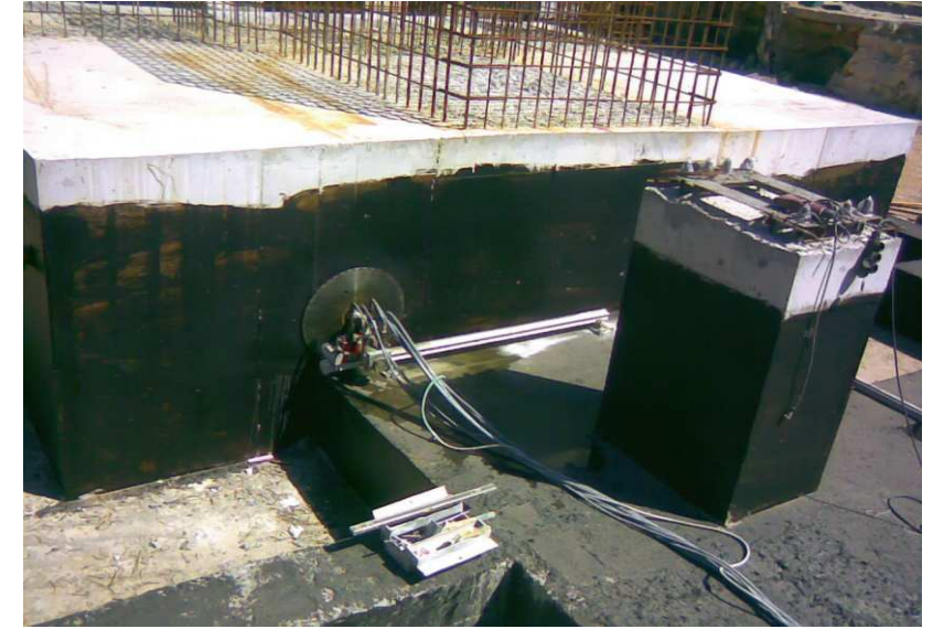
Karot makinası ile delik açma
