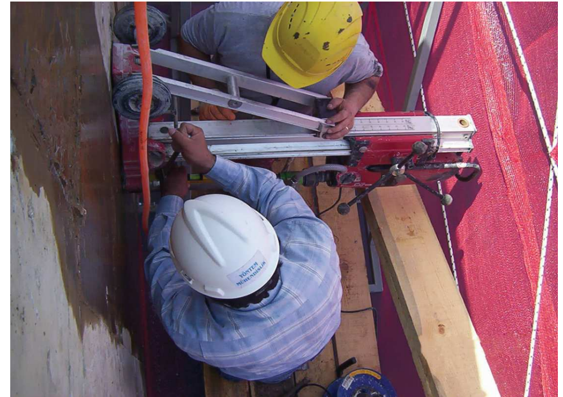
Karot makinası ile delik açma
