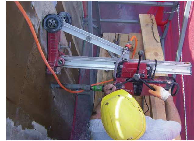
Karot makinası ile delik açma
