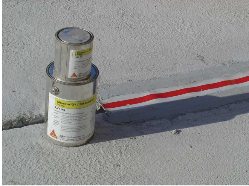
Yapı Derzlerinde Dilatasyon Bandı Uygulaması
